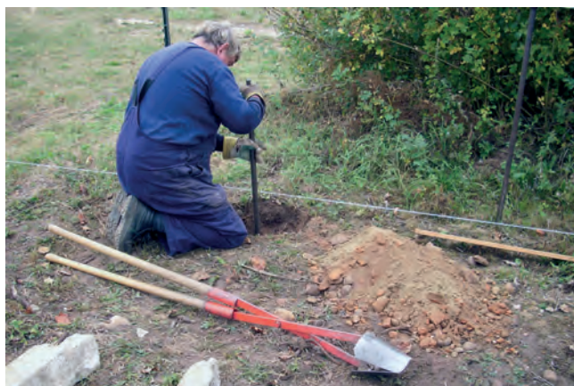
Pfosten von Hand einzugraben ist harte Arbeit und dauert lange, auch mit einem Lochspaten.
