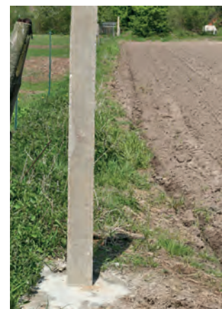
Einbetoniert: Eckpfosten müssen extrem fest sitzen.
