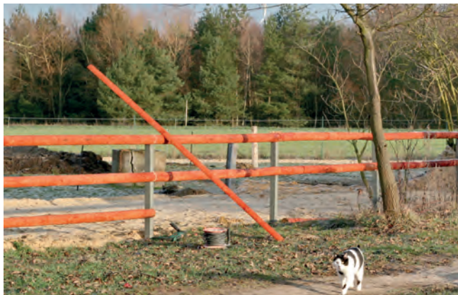
Die Querlatten sollten zwei Pfahlabstände lang sein und werden auf der Pferdeseite der Pfosten angeschraubt.
