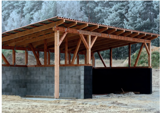
Ein ganz anderes Konzept, Niedersachsen: Vorschriftenmäßige Dunglege mitten in einem Auslauf. Das Dach verhindert Auswaschen.
