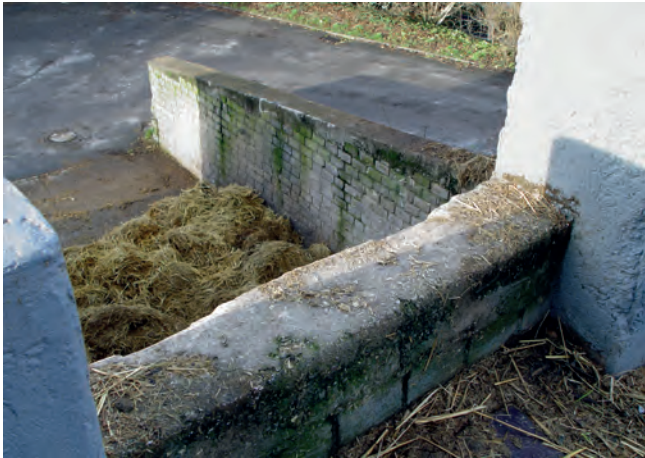
Genehmigt, praktisch, gegen Sickerwasser durch Betonboden geschützt: Dunglagerstätte in der Stadt, Nordrhein-Westfalen.
